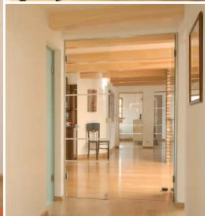
2-k ídlé otočné dveře do AL zárubni st. ot.: 1475/2173 mm
